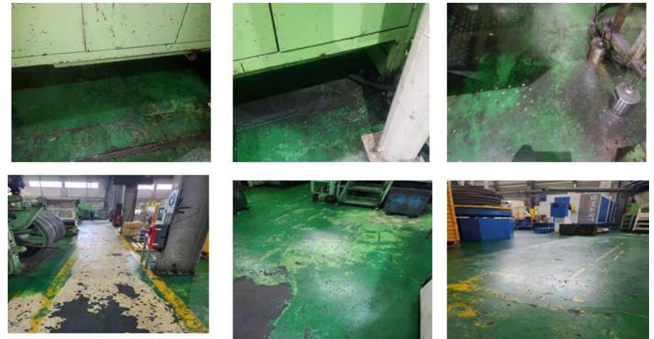
<그림 3-1> 기름 먼지가 쌓인 공장 바닥
