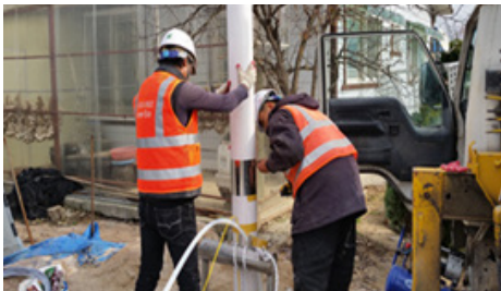
물 공급 취약마을 공용 지하수 음수대 설치 사업
